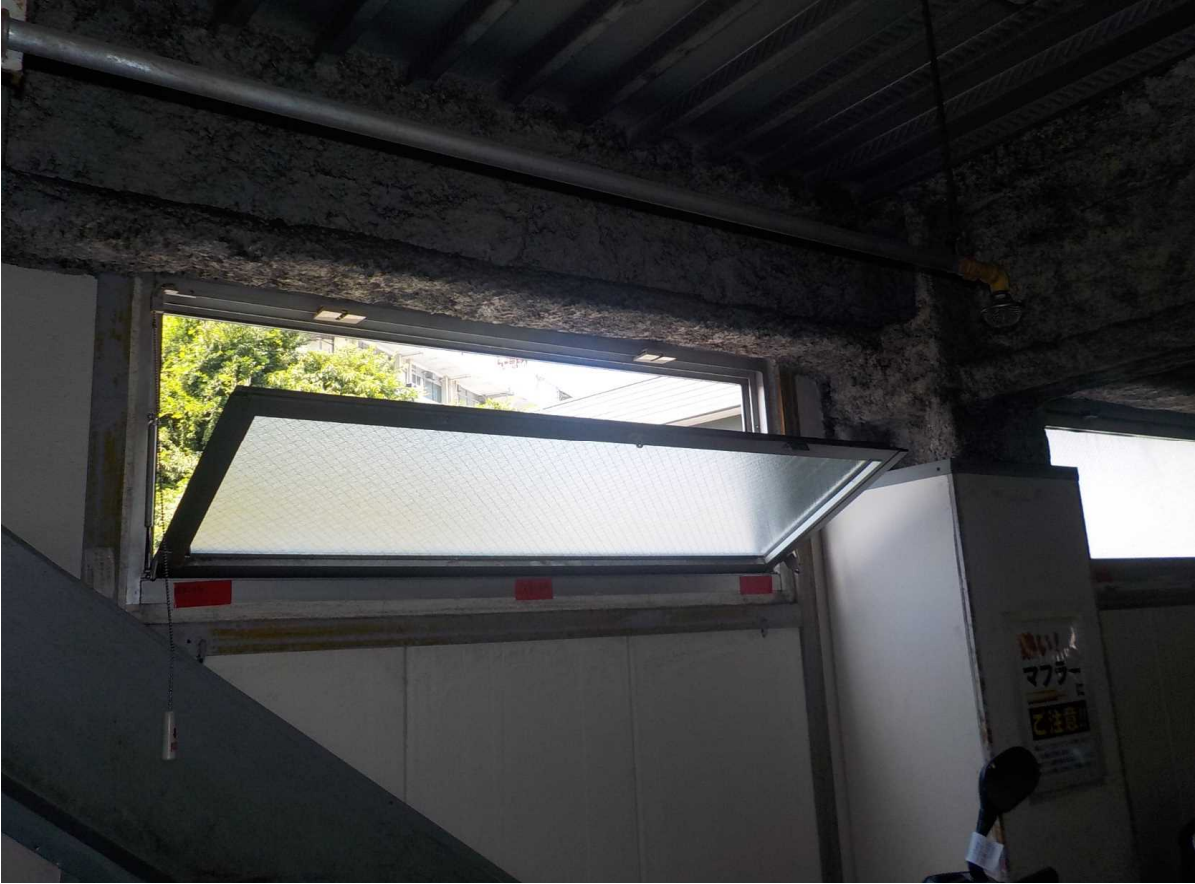
追浜駅第1自転車等駐車場排煙窓写真
