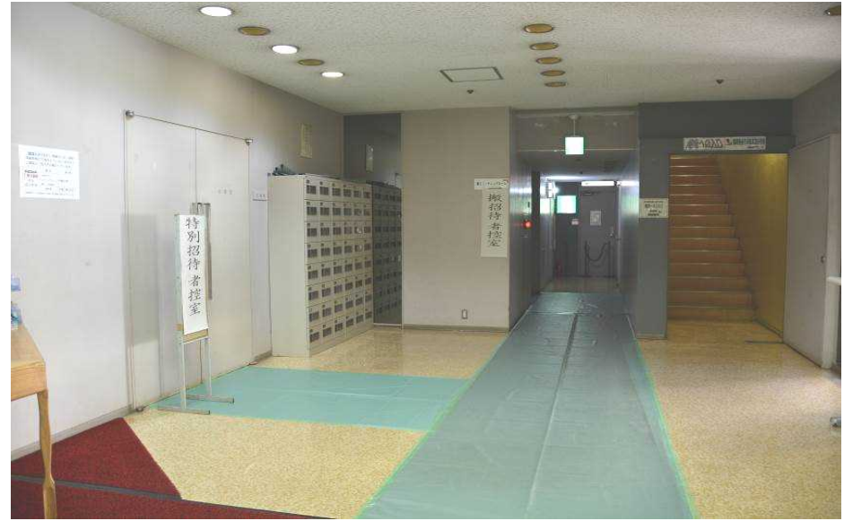
写真⑱ 控室前床養生 イメージ
