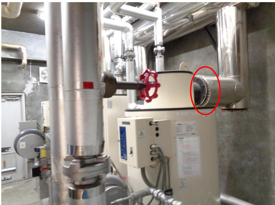
No. 20 空調設備3階 貯湯槽廻り：給水管の曲がり部分の白色部分の保温材
