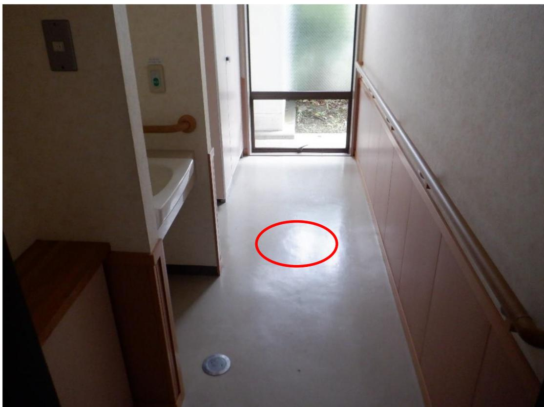
No. 1 2 1階 湯沸室 床：長尺塩ビシート（接着剤を含む。）
