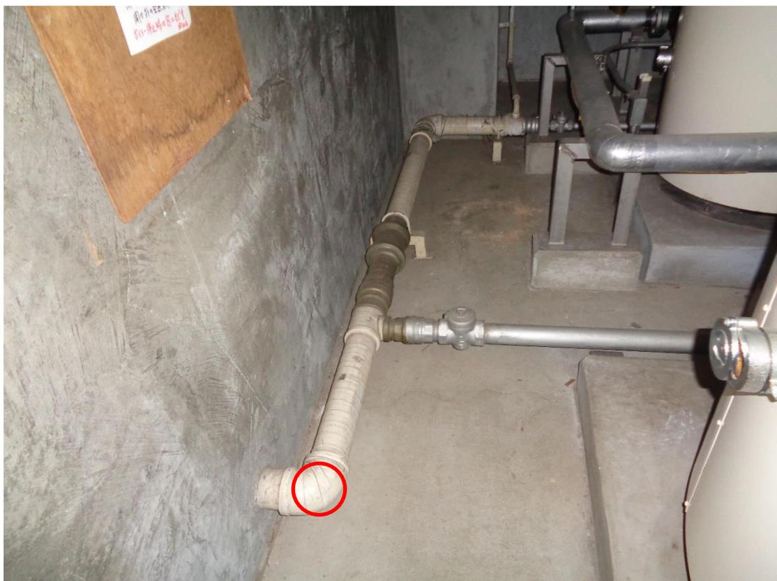
No. 19 1階 機械室 ボイラーの煙道接続部分のパッキン
