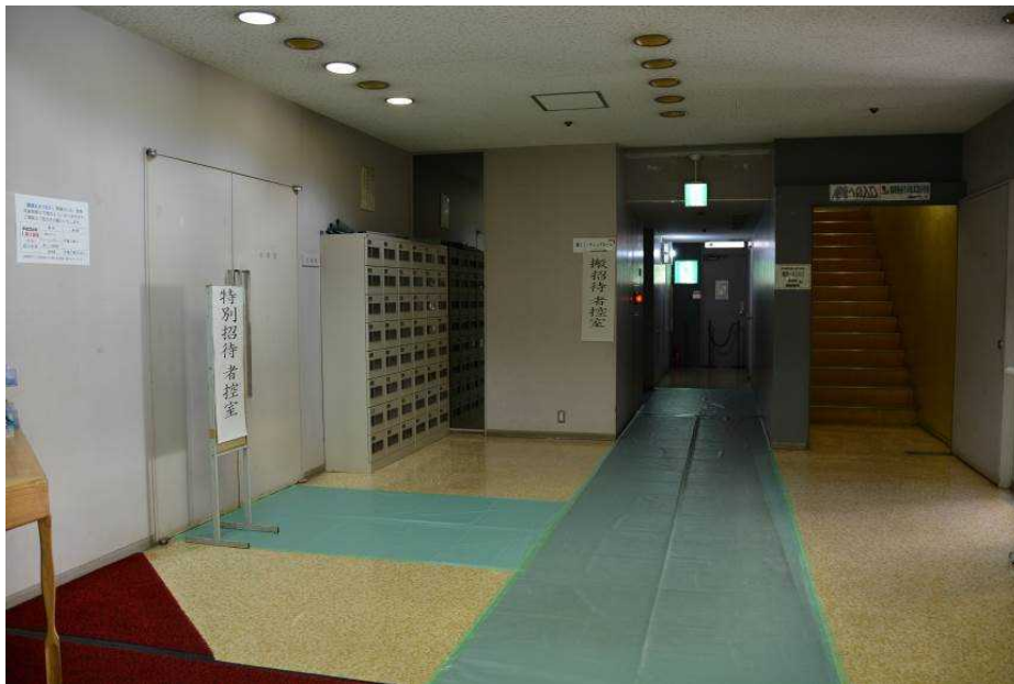
写真③ 控室前床養生その1
