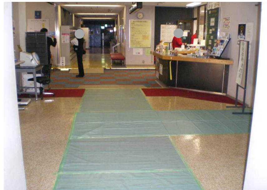
写真④ 控室前床養生その2
