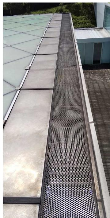
屋上グレーチングの下は泥や落ち葉などが溜まりやすい。下から見て目立つ部分は取り除くこと。また、屋根の排水溝は目詰まりを起こすと排水機能が損なわれる。落ち葉やゴミの除去等の清掃を行うこと。清掃の際、排水溝は屋根のキワにあるため安全带等の落下防止措置を必ず行うこと。
