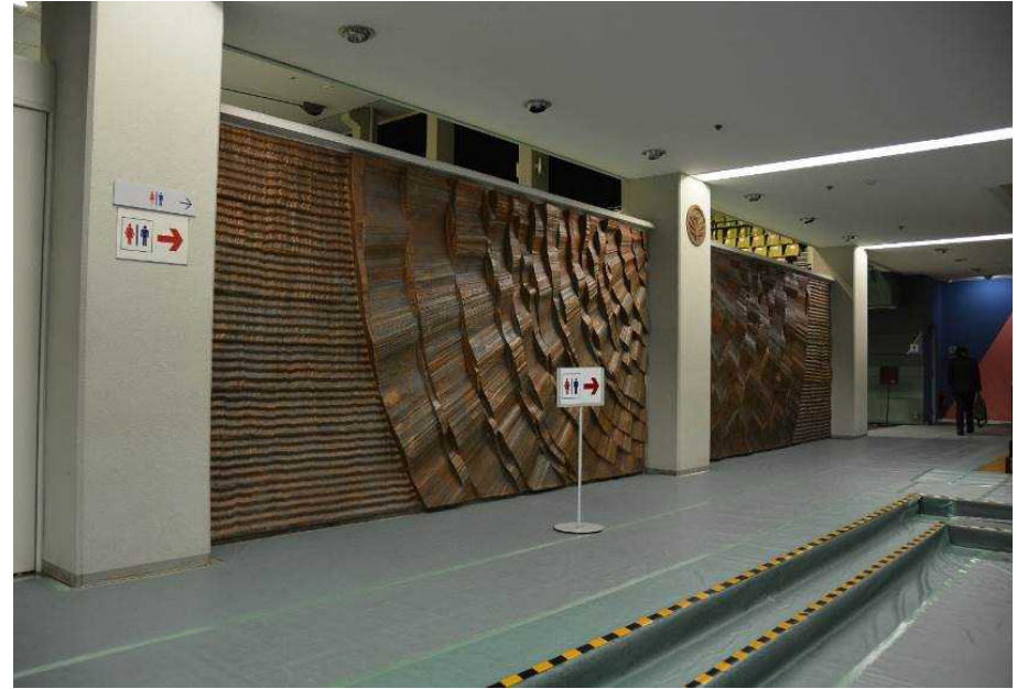
写真② トラテープ (段差注意)
