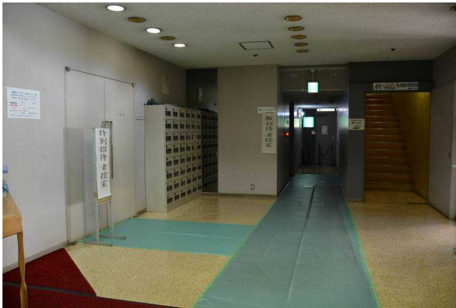
写真③ 控室前床養生その1
