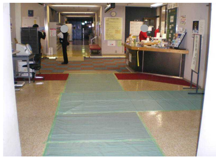
写真④ 控室前床養生その2
