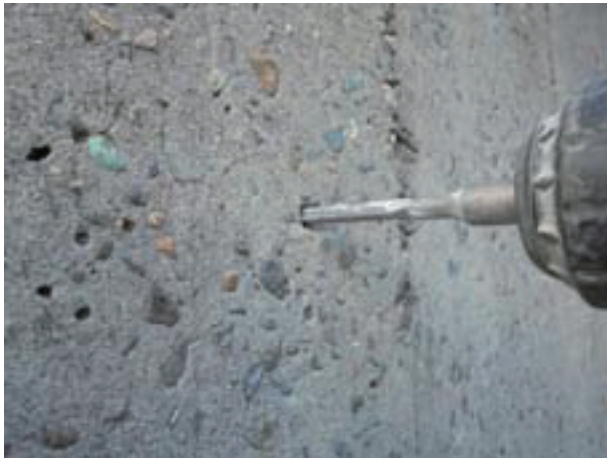
1 コンクリート 穴あけ作業6mm
