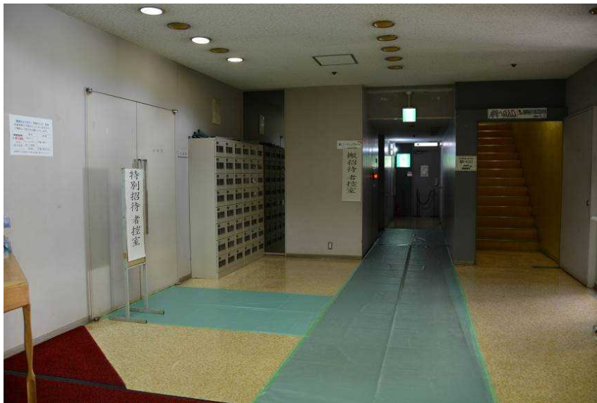
写真 控室前床養生その1
