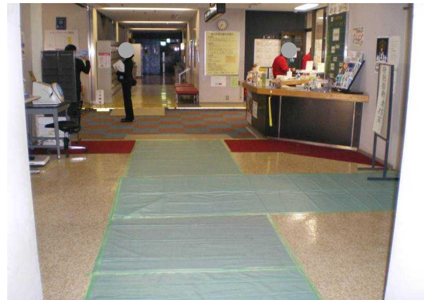
写真 控室前床養生その2
