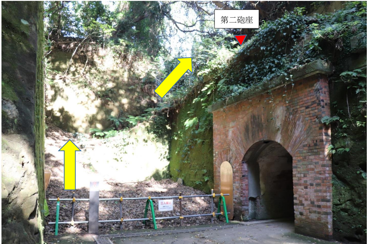
写真1 猿島砲台跡第一砲台第二砲座へ接続する階段
