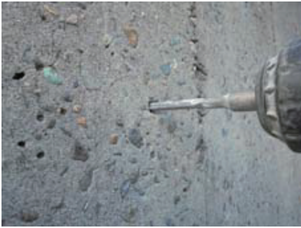
1 コンクリート 穴あけ作業6mm
