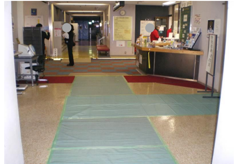
写真⑥ 控室前床養生その2
