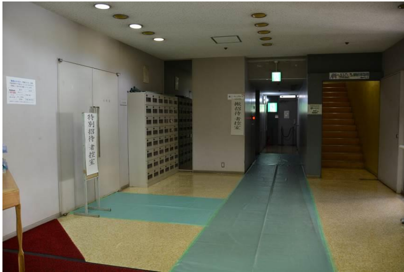
写真⑤ 控室前床養生その1
